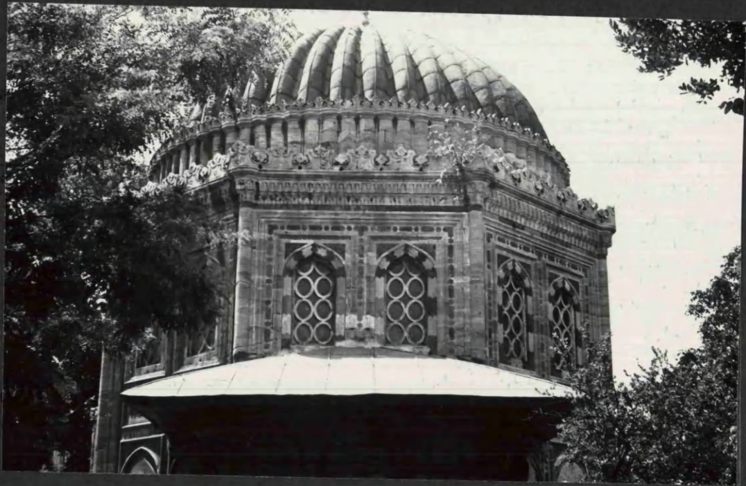
FIG. 124 THE ŞEHZADE MEHMET TÜRBESİ
