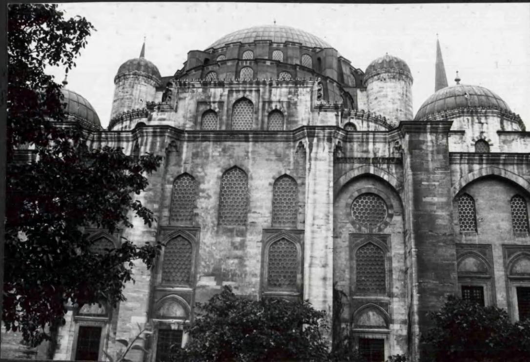
FIG. 33 THE QIBLA FAÇADE
